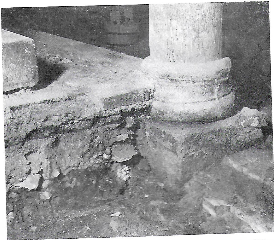
3. Kraków — Wawel. Krypta św. Leonarda. Wykopaliska A. Szyszko-Buhusza z 1938 r. Widoczna relacja pomiędzy poziomami posadzek a bazą kolumny romańskiej. Fot. w PZS
