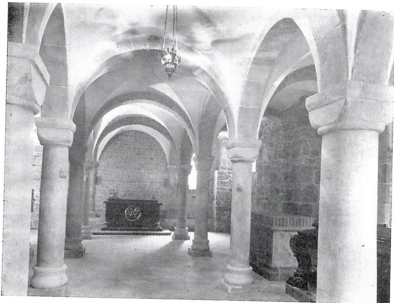
2. Kraków — Wawel. Krypta św. Leonarda po odnowieniu przez A. Szyszko-Bohusza. Widok w kierunku zachodnim. Fot. w PZS
