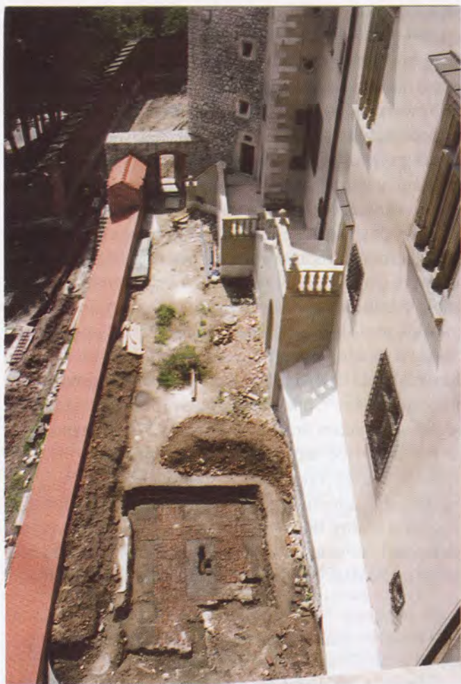
6. Górny taras z odsłoniętą częścią ścieżek w r. 2003; widok z wieży Duńskiej ku Jordance (fot. J. Firlet)
