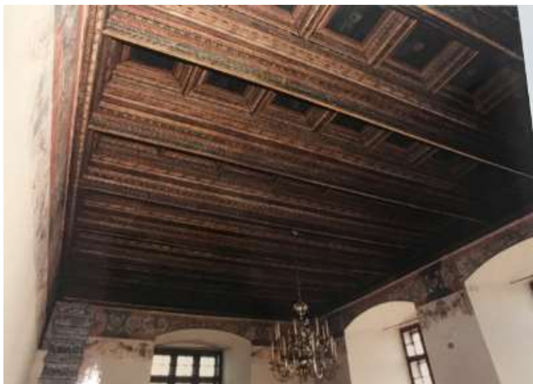
Fot. 2 Fragment stropu drewnianego belkowo-kasetonowego w sali nr 104 pierwszego piętra wschodniego skrzydła Zamku Królewskiego na Wawelu.
