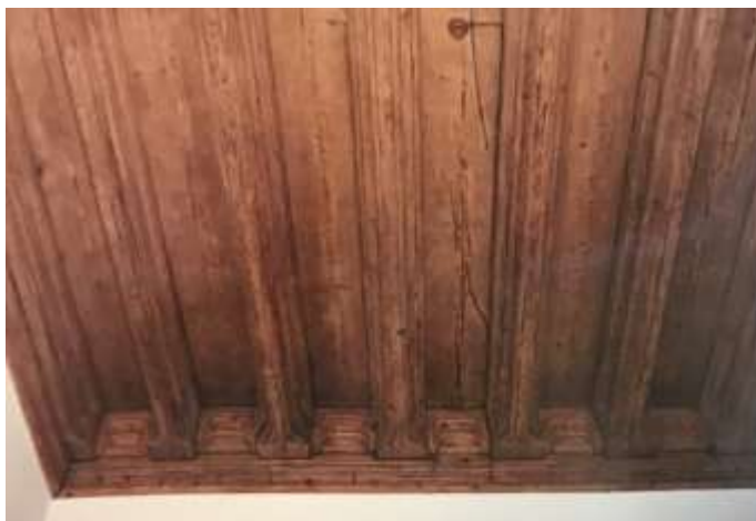
Fot. 1 Fragment stropu drewnianego gęstobelkowego w sali nr 004 parteru wschodniego skrzydła Zamku Królewskiego na Wawelu.
