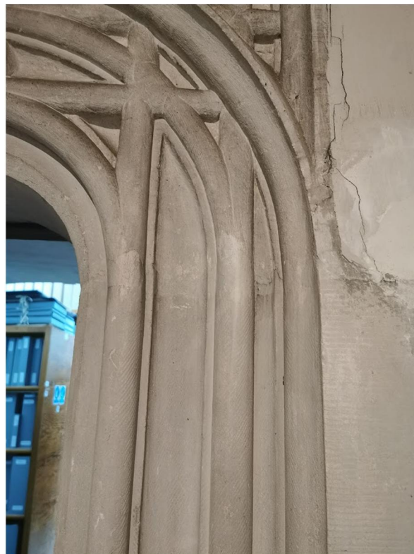
Fot. 13. Portal z Sali 53, widoczne uzupełnienia kitami, zabrudzenie powierzchni
