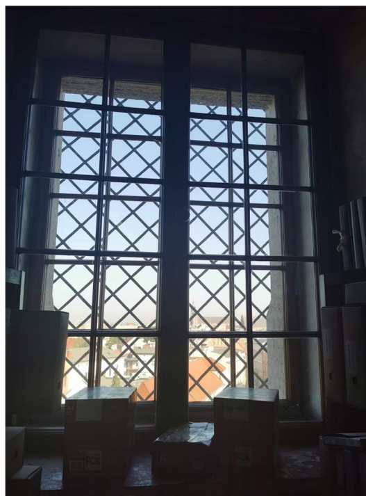
Fot. 16. Okno od strony zewnętrznej
