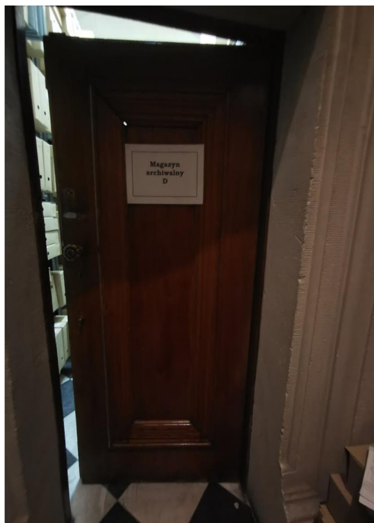
Fot. 15. Drzwi drewniane w Sali 058
