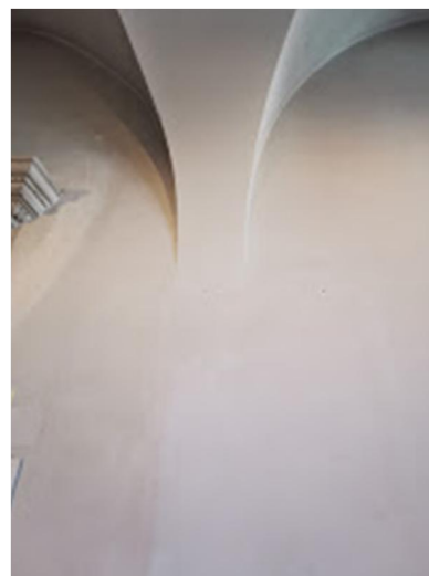
Fot. 2. Tynki w 053
