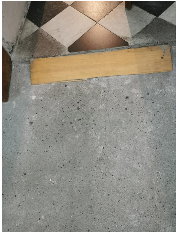
Fot. 4.. Sala 055 z usuniętą posadzką
