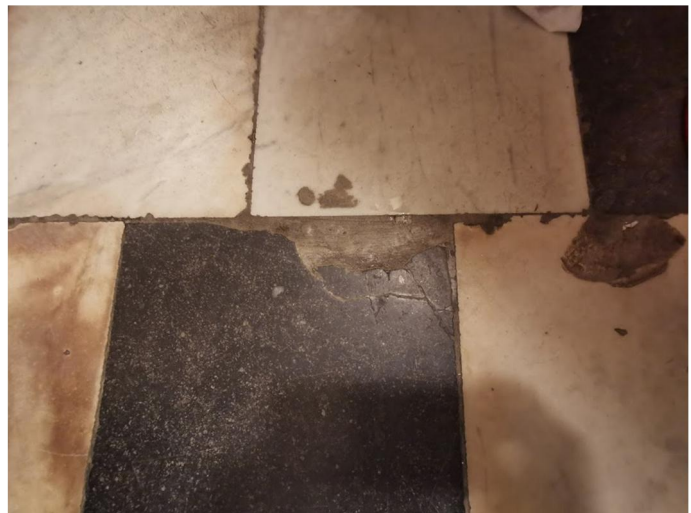
Fot. 5. Ubytki i zabrudzenia posadzki
