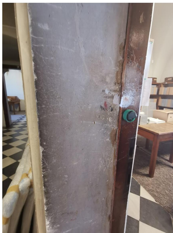
Fot. 14 Portal z Sali 053. Ściana pd. widoczne zatłuszczenia i ubytki kamienia
