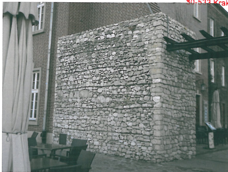
Fot.7 Fragment odrestaurowanego muru przy budynku nr 8.
