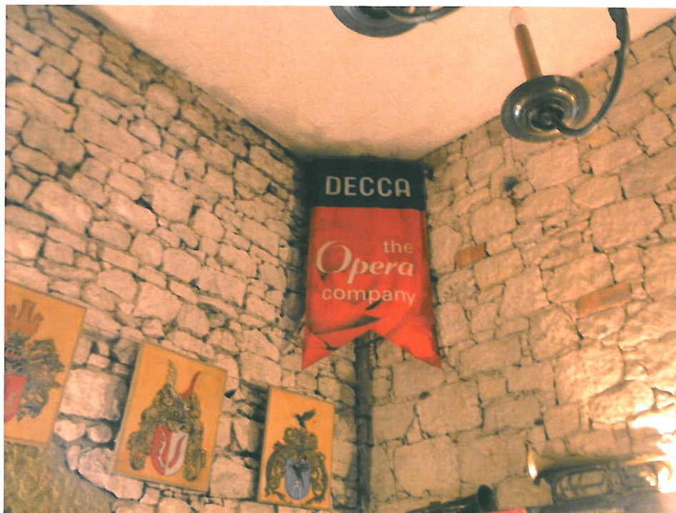
Fot.15 Zawilgocenie wewnętrzne muru baszty Szlacheckiej zlokalizowane w narożniku ściany pod stropem.
