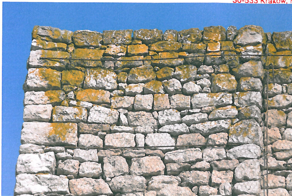
Fot.16 Luźnie i odspojone fragmenty muru nad basztą Tęczyńska - narożnik.
