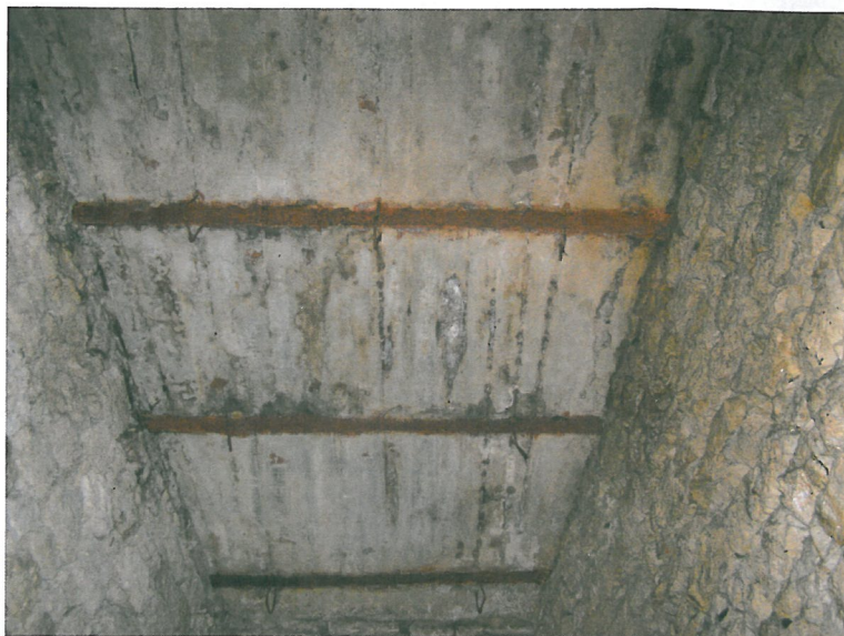
Fot.11 Strop nad piwnicą w baszcie Panieńskiej
