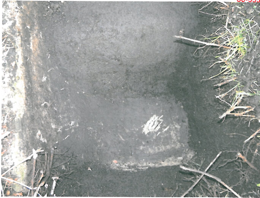
Fot.21 Dno korytka odwadniającego formuje wylewka betonowa.
