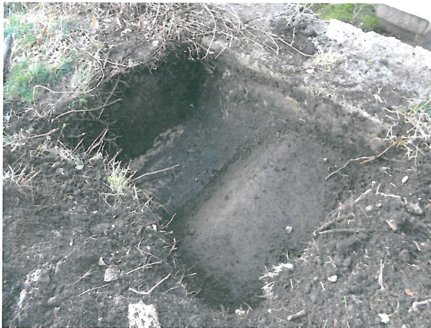
Fot.20 Odkrywka korytka odwadniającego.
