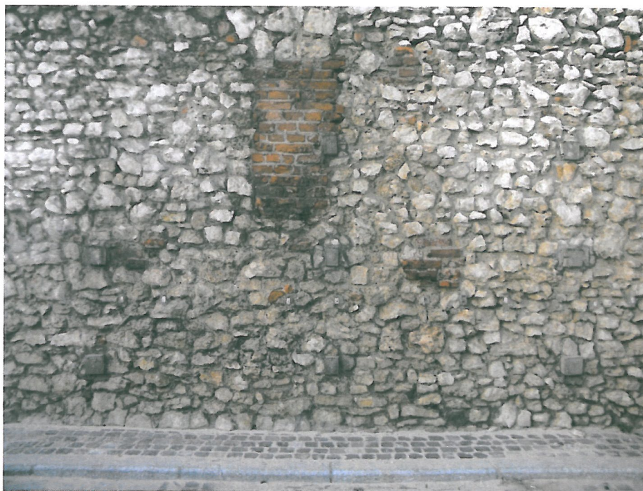
Fot.18 Widok belek osadzonych i pozostawionych w murze.
