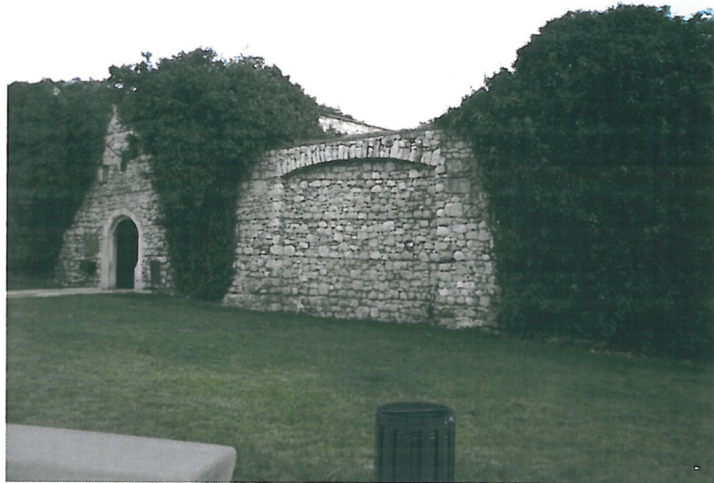
Fot.3 Widok roślinności pokrywającej mur od strony dziedzińca.
