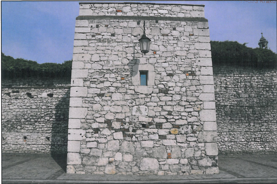
Fot.25 Południowy odcinek wew. muru obwodowego – od strony międzymurza, Baszta Szlachecka. W rekonstruowanych wątkach kamiennych umieszczone pojedyncze cegły gotyckie. Czerwiec 2016r. M.Wida
