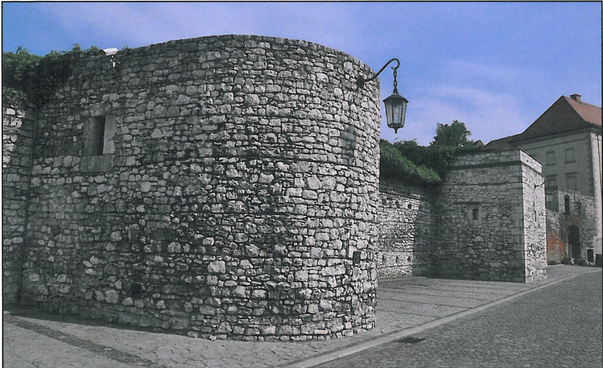
Fot.29 Południowy odcinek wew. muru obwodowego – od strony międzymurza, widok od Baszty Panieńskiej. Wątki kamienne pokryte warstwą brudu. Czerwiec 2016r. M.Wida
