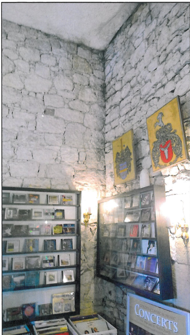
Fot.35,36 Południowy odcinek wew. muru obwodowego – Wnętrze Baszty Szlacheckiej (sklepik muzyczny). Narożnik ściany zawilgocony (nieszczelność dachu), wątki kamienne ścian w dobrym stanie. Czerwiec 2016r. M.Wida
