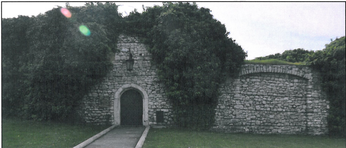
Fot.5 Południowy odcinek wew. muru obwodowego – od strony dziedzińca zewnętrznego. Środkowy fragment rekonstruowanego odcinka - wejście do Baszty Szlacheckiej. Ściany obrosnięte bluszczem. Czerwiec 2016r. M.Wida
