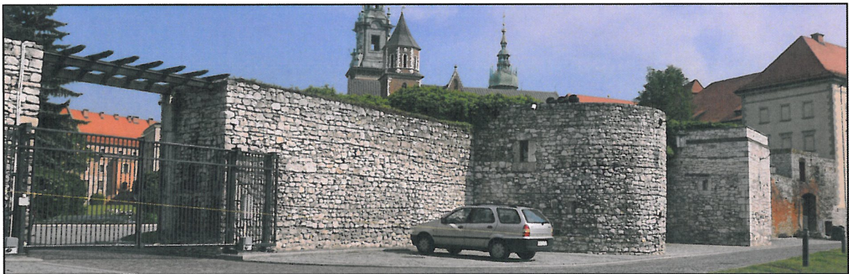
widok od strony międzymurza
