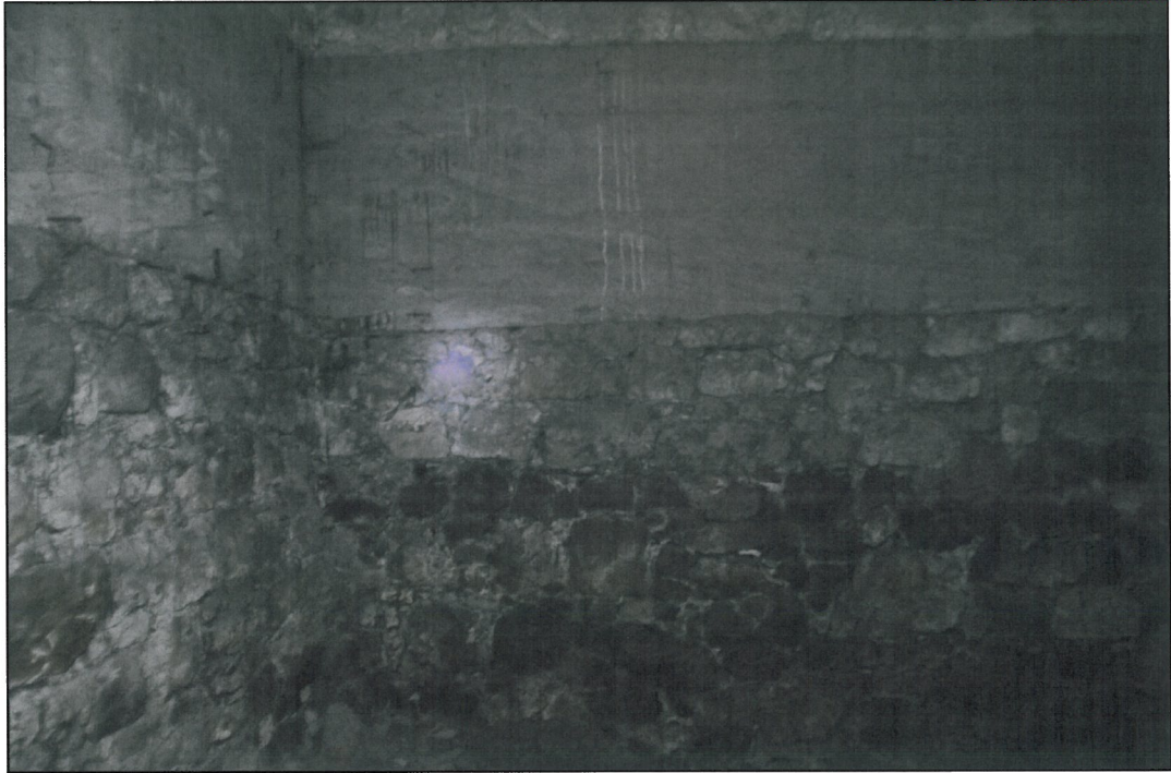
Pod wieńcem żelbetowym oryginalne wątki kamienne baszty Szlacheckiej
