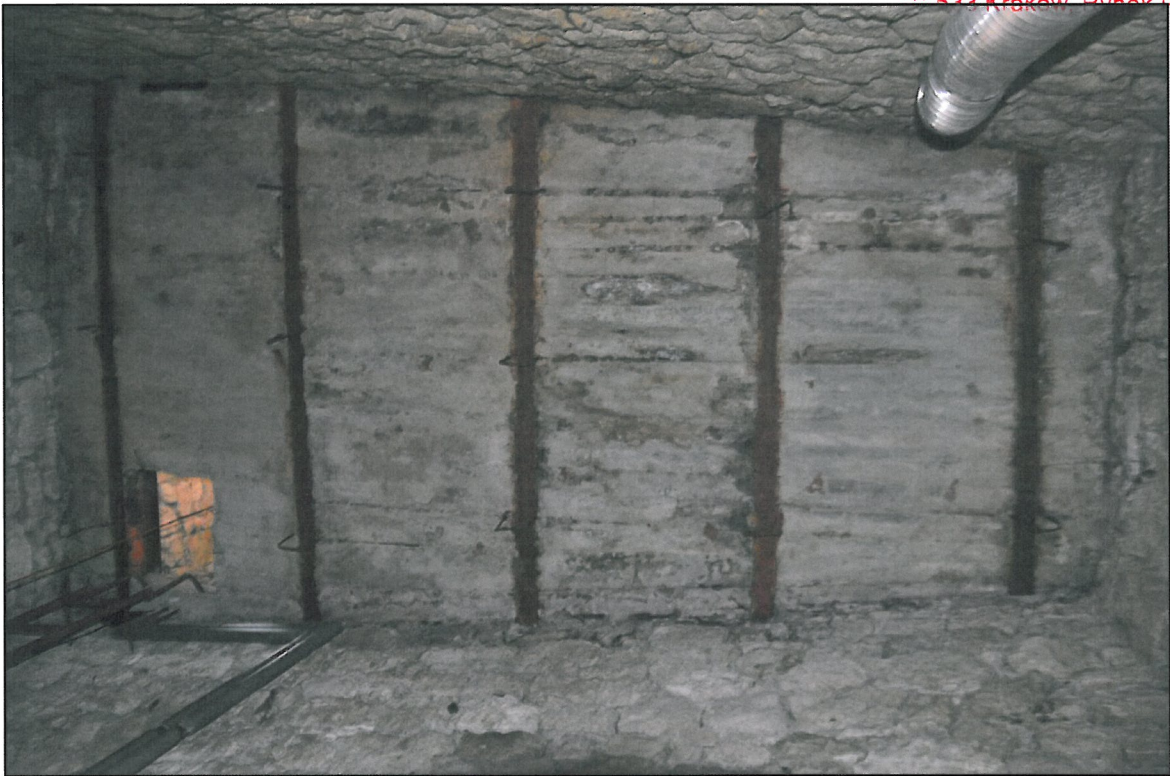
Fot.45 Południowy odcinek wew. muru obwodowego – Piwnica Baszty Panieńskiej . Płyta żelbetowa w stropie piwnicy. Belki stalowe ze śladami korozji. Czerwiec 2016r. M.Wida
