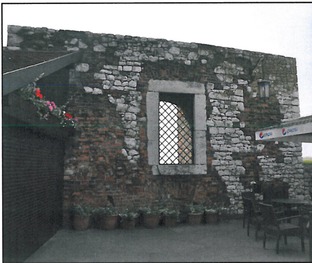
widok strony dziedzińca zewnętrznego
