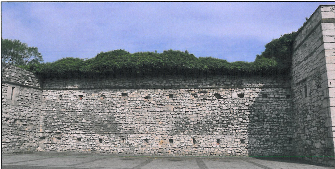
Fot.26 Południowy odcinek wew. muru obwodowego – od strony międzymurza. Odcinek między basztami. W licu muru regularne otwory po montażu belek kotwiących stojącego tu dawniej budynku (do zamurowania zgodnie z wątkiem). Czerwiec 2016r. M.Wida
