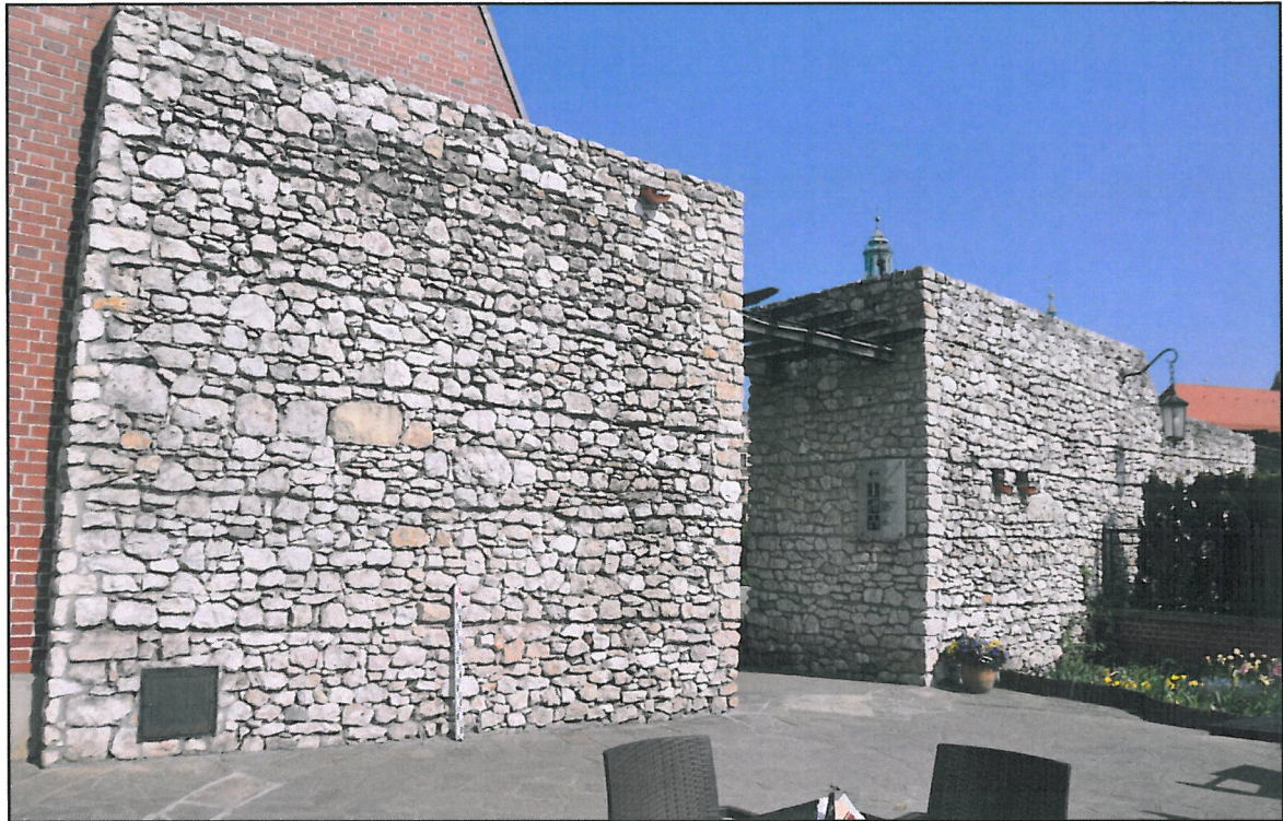
Fot.33 Południowy odcinek wew. muru obwodowego – od strony międzymurza. Przejście dla ruchu pieszego zadaszone ażurową drewnianą konstrukcją. Stan lica kamiennego dobry. Czerwiec 2016r. M.Wida
