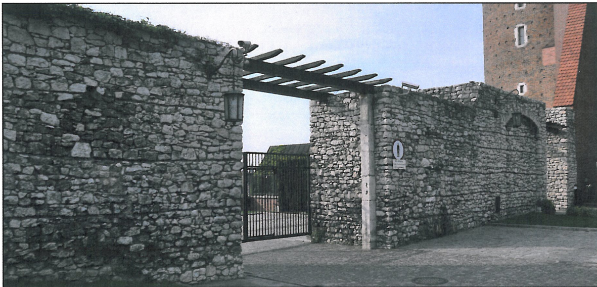
Brama w murze umożliwiająca wjazd samochodów.
