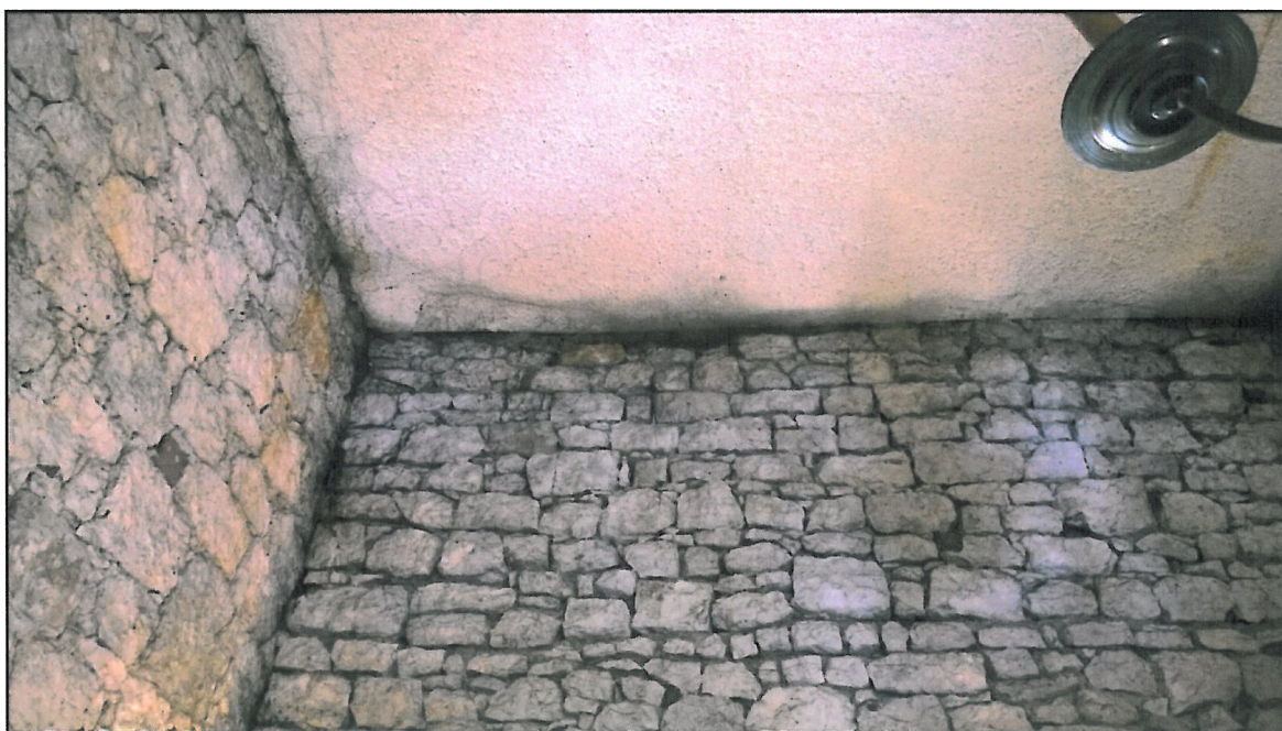
Fot.35,36 Południowy odcinek wew. muru obwodowego – Wnętrze Baszty Szlacheckiej (sklepik muzyczny). Narożnik ściany zawilgocony (nieszczelność dachu), wątki kamienne ścian w dobrym stanie. Czerwiec 2016r. M.Wida
