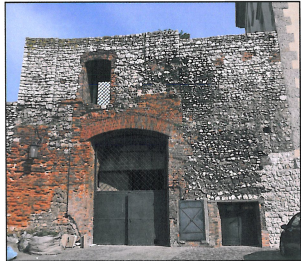
widok od strony międzymurza
