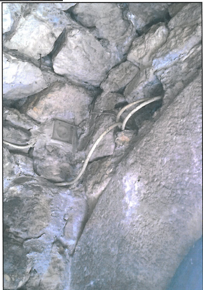
Fot.44 Południowy odcinek wew. muru obwodowego – Wnętrze Baszty Panieńskiej (przewodnicy). Kabel do gniazdka poprowadzony po licu. Czerwiec 2016r. M.Wida
