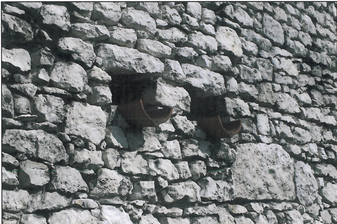
Fot.34 Południowy odcinek wew. muru obwodowego – od strony międzymurza. Rzygacze ceramiczne Czerwiec 2016r. M.Wida
