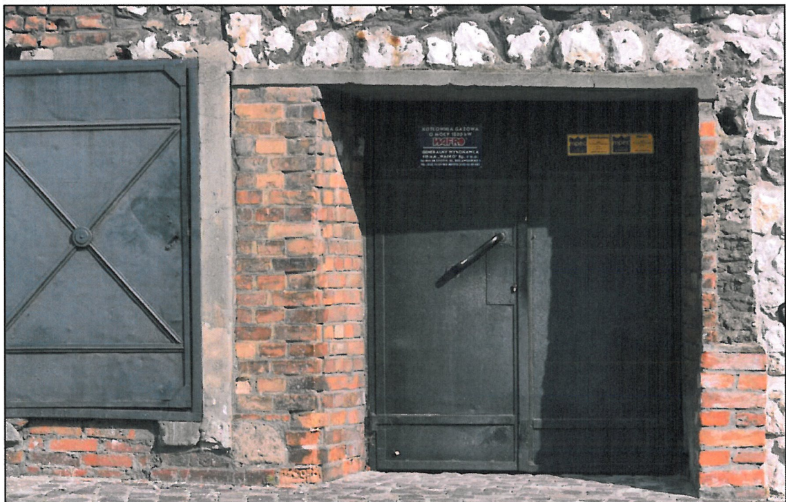
Fot.20 Południowy odcinek wew. muru obwodowego – od strony międzymurza. Fragment Baszty Tęczyńskiej. Wejście do kotłowni, prawy węgar wejścia do rekonstrukcji. Czerwiec 2016r. M.Wida
