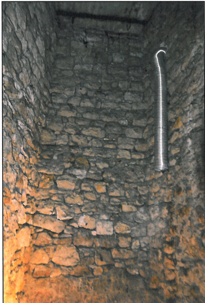
Fot.45 Południowy odcinek wew. muru obwodowego – Piwnica Baszty Panieńskiej . Płyta żelbetowa w stropie piwnicy. Belki stalowe ze śladami korozji. Czerwiec 2016r. M.Wida
