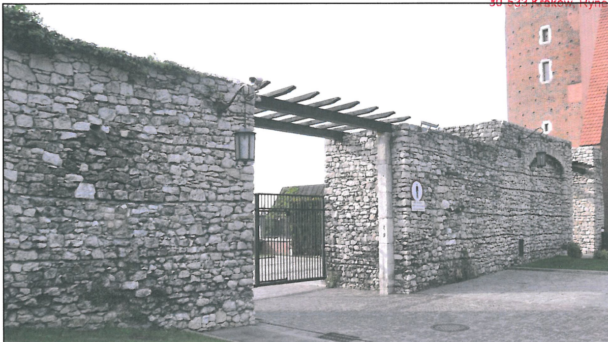
Fot.11 Południowy odcinek wew. muru obwodowego – od strony dziedzińca zewnętrznego, brama wjazdowa na teren międzymurza. Wątki kamienne pokryte warstwą brudu. Czerwiec 2016r. M.Wida
