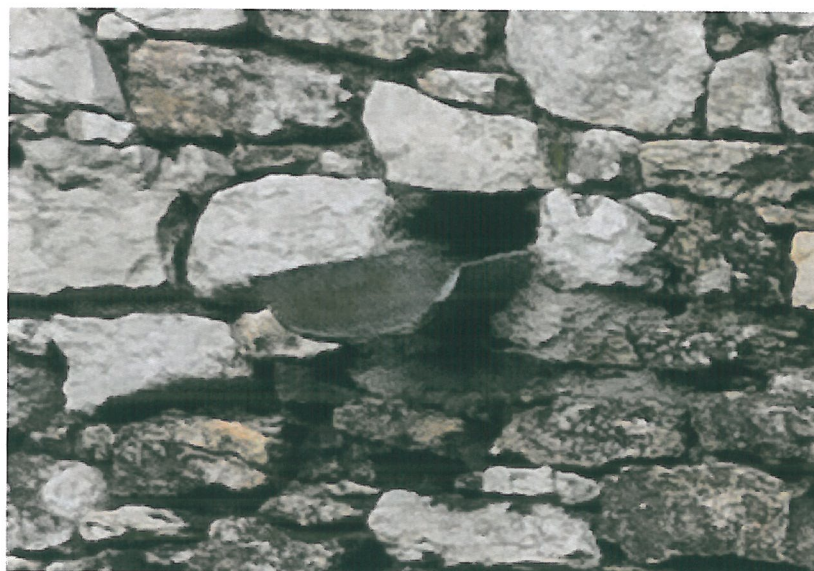
Rzygacze znajdujące się w pobliżu bramy automatycznej od strony dziedzińca do usunięcia i zastąpienia nowymi ceramicznymi
