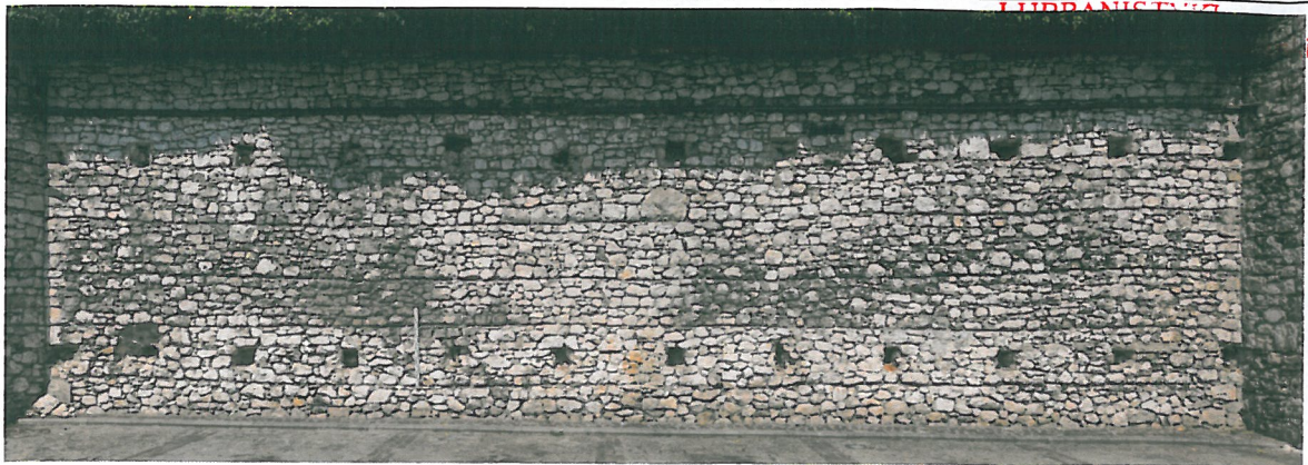
Ubytki ciosów wapiennych jako efekt usunięcia konstrukcji budynku „Sanatorium” przeznaczone do zamurowania
