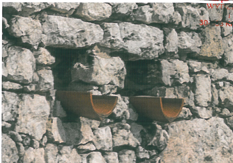
Rzygacze ceramiczne znajdujące się od strony międzymurza, które mogą posłużyć za przykład nowych osadzanych w istniejących kanałach odwodnieniowych
