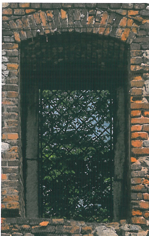
Okno, na którym należy osadzić parapet z blachy (widok od strony międzymurza)
