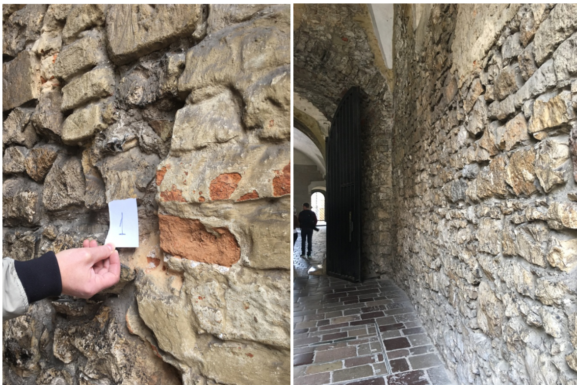
Fot.4. stan zachowania wątków na ścianie północnej ( część B ) – ubytki w wyprawie wapiennej
