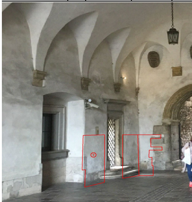
Fot. 1 . zakres prac dla tynków renowacyjnych ( część zachodnia sieni )
